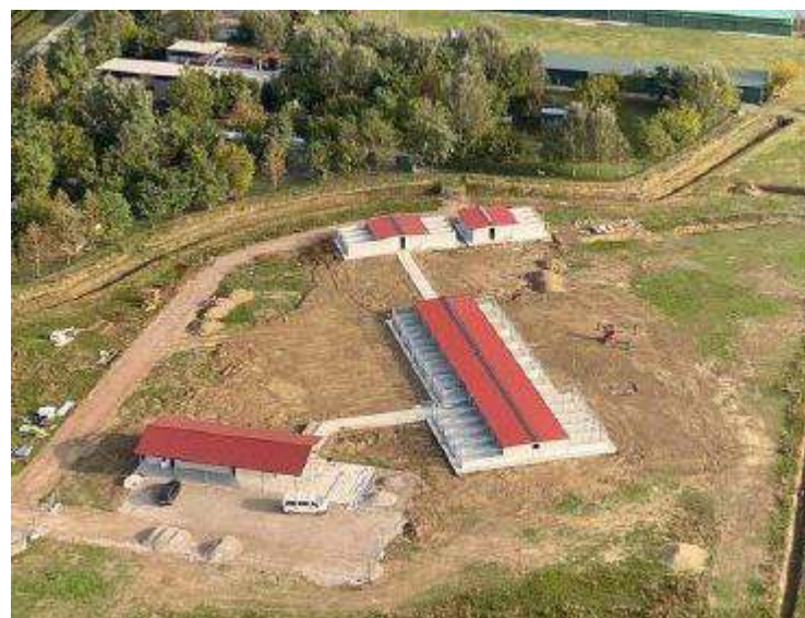
I lavori per la costruzione della nuova struttura sono in corso
